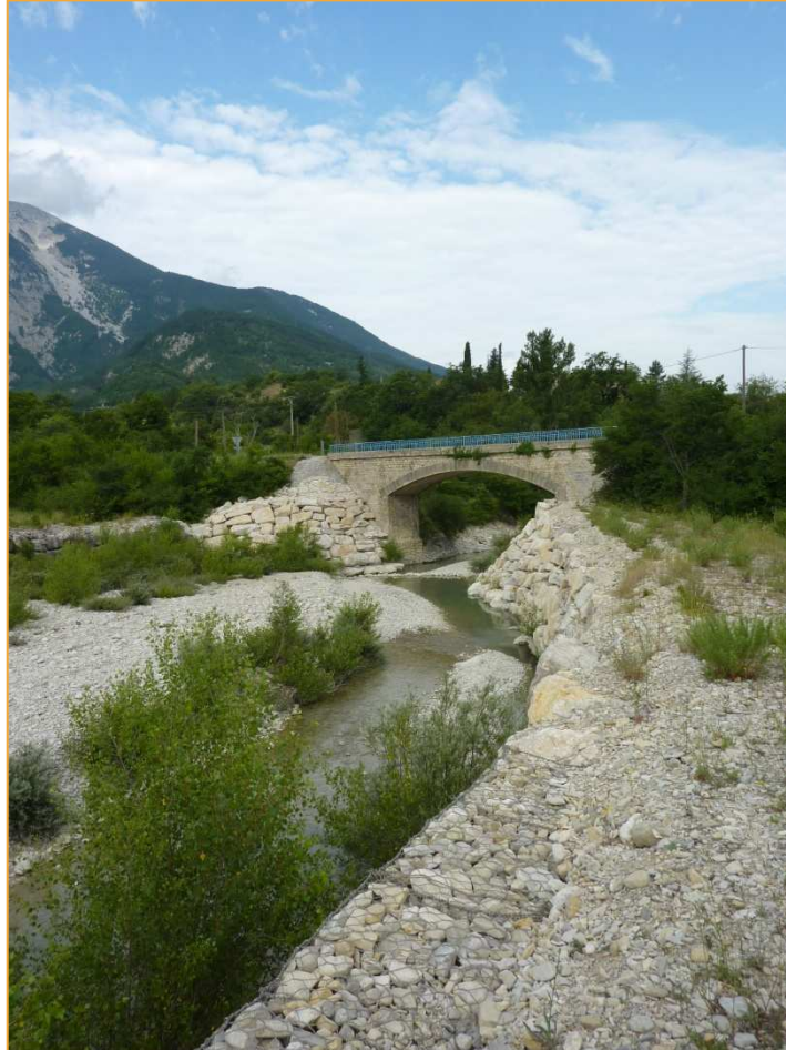
Figure 60 : Pont pour voir ferrée sur le Toulourenc, Brantes ,22.07.2010, N. Borel
