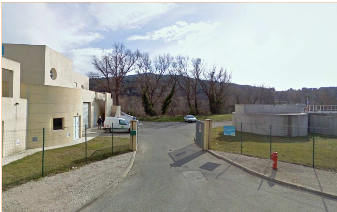
Figure 15 : Station d'épuration de Vaison la Romaine, 2011, Google Street View
