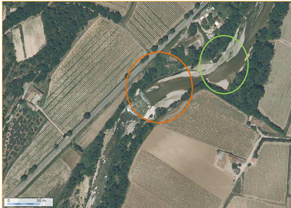
Figure 56 : Orthophotographie du seuil de Roaix, 2007-2011, Géoportail, IGN.
