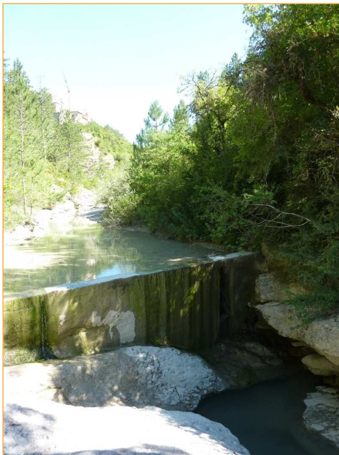
Figure 67 : Seuil modifiant la dynamique du Toulourenc, Aulan, 04.08.2010, N. Borel
