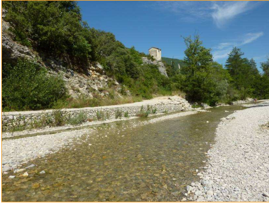
Figure 65: Photographie d'un gabion sur le Toulourenc, 22.07.2010, N. Borel
