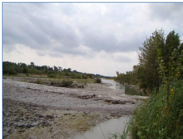
Aval du seuil
