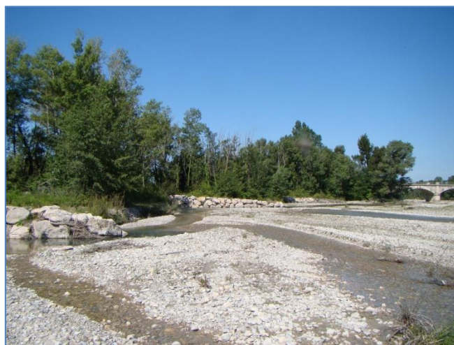
Epis à l'amont du pont de Buisson
