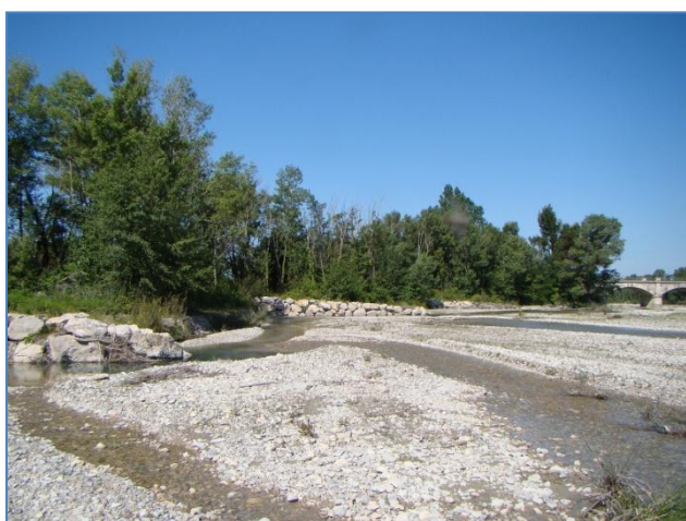
Epis à l'amont du pont de Buisson
