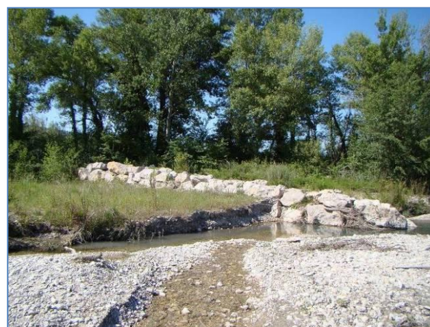
Epis à l'amont du pont de Buisson
