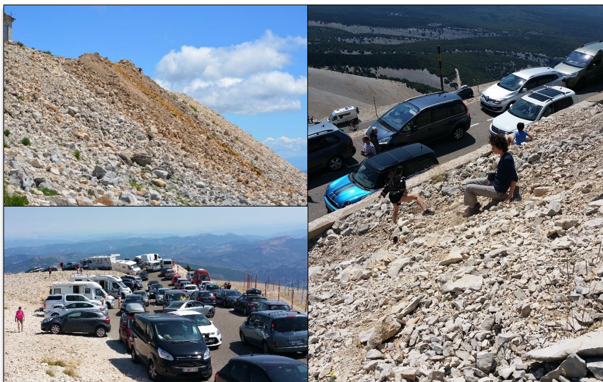
Image 19 : Panoplie de situations au sommet : dégradation et altération des pierriers et des espèces protégées qu'il contient, circulation piétonne dangereuse et saturation des voies de circulations
