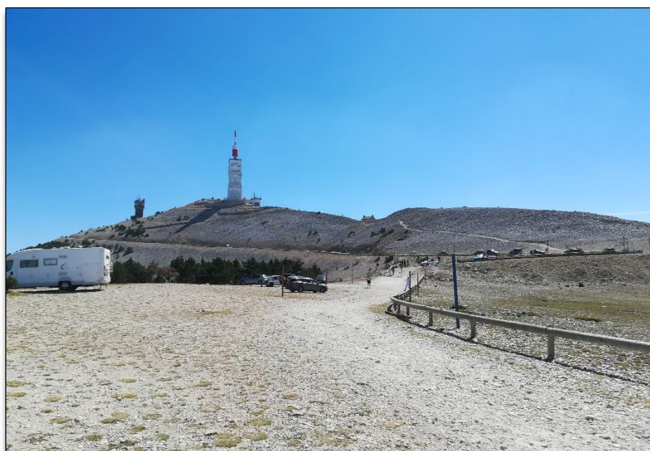
Image 1 : Matérialisation des limites du parking du radome - 2017
